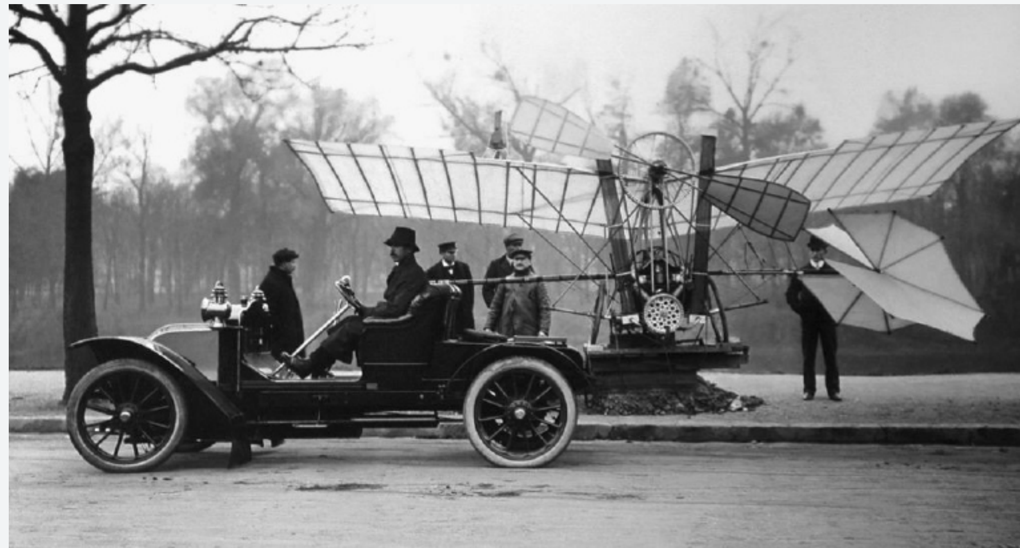
Alberto Santos-Dumont transportando o primeiro avião chamado número 20 em seu automóvel pessoal em Paris, no final de 1908, possivelmente em 12 de novembro. Esta aeronave tem 12 ou 13 costelas por asa, enquanto a número 19 tinha apenas 6 ou 7.
